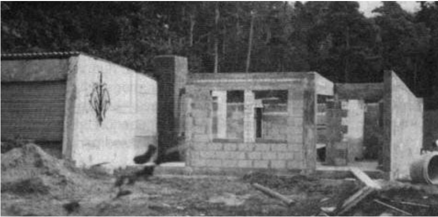
Rohbau des Stammesheimes
